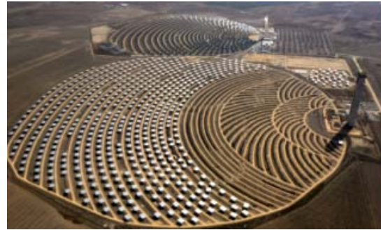
PS-10 /PS-20 (© Abengoa)
